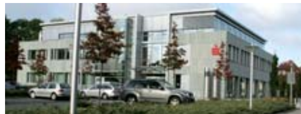
Heizen und Kühlen mit Erdwärme in der Sparkasse Heiligenstadt
