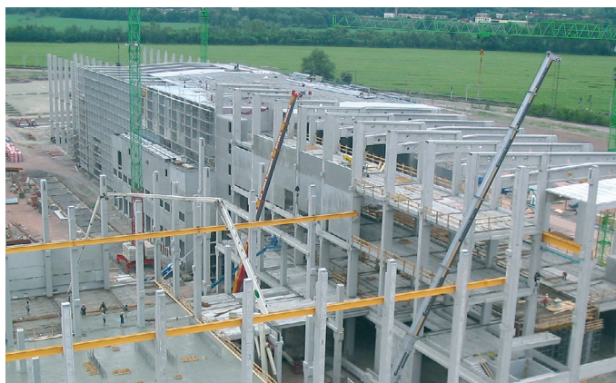
Papierfabrik Schwarzka – Rohbau aus Betonfertigteilen
