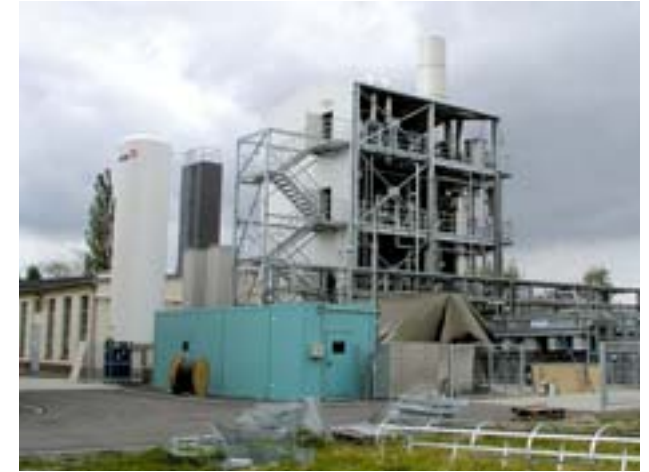
HP-POX-Technikumsanlage 100 bar, 5 MWth der TU Bergakademie Freiberg
